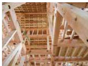
木造軸組工法は、台、柱、梁で建物の骨組みをつくり、耐力壁をバランスよく配置。設計の自由度が高く、複雑な形状の土地にも対応可能。
